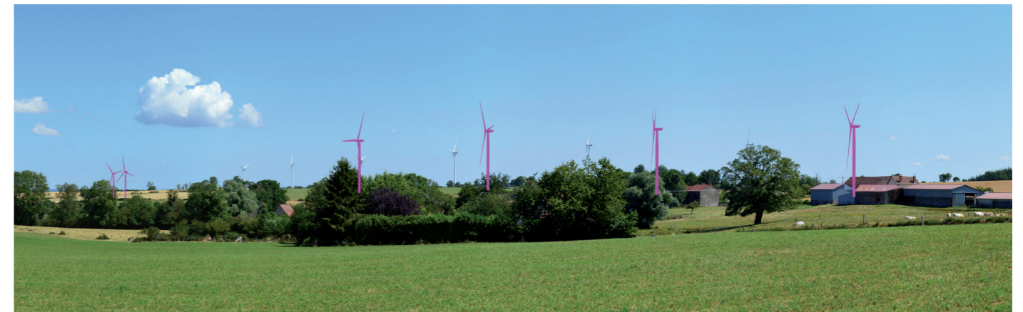
Photographie 153 : Vue sur le projet éolien en esquisse depuis les abords de la D25, au sud de Lonlevade (Vue 27 du carnet de photomontages en annexe).
